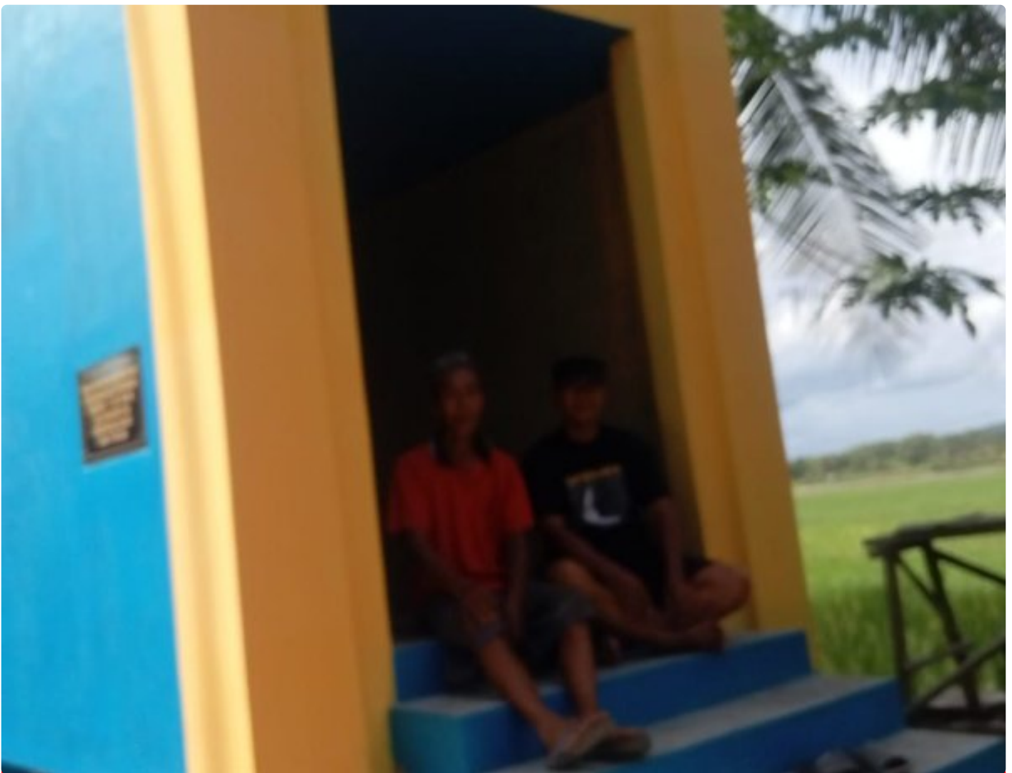
Pembangunan Irigasi Perpompaan di Desa Binangun
